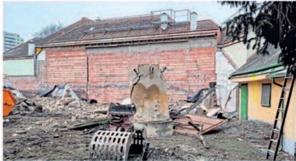
Kurz vor Weihnachten fuhren die Bagger auf und demolierten das Kleinod.
