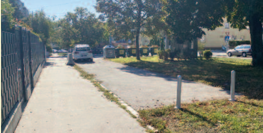
Maßnahmen gegen unrechtmäßiges Parken: 2 Poller und eine Betonleitwand (Hintergrund)
