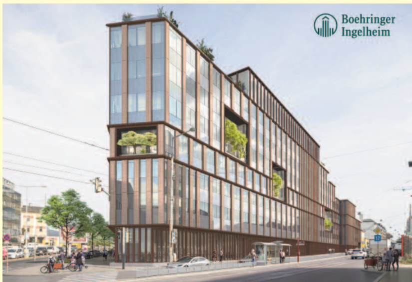
Der selbe Standort in zwei Jahren, dann aber mit 62er-Station!
