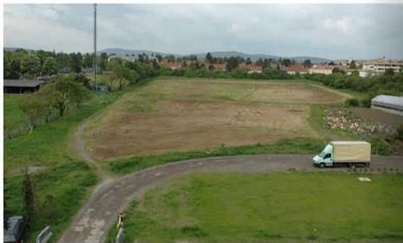
Braun statt grün: Nach den Rodungsarbeiten ist von der Wiese nicht mehr viel übrig.
